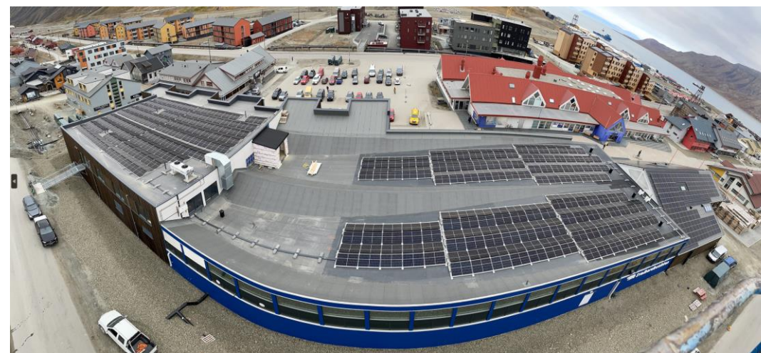
Solceller på COOP Svalbardbutikken, 300 kWp, 2022
